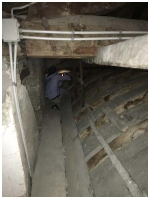
Camminamento perimetrale all'estradosso della volta. Mancano alcune parti di assito e in alcuni tratti le reni della volta sono piene di detriti e oggetti. L'intervento prevede la pulizia dei detriti e la sostituzione o integrazioni delle parti di assito ammorlate o mancanti con legno stagionato di ugual essenza. Successivamente l'intero impalcato perimetrale verrà trattato con biocidi e antitarlo.
