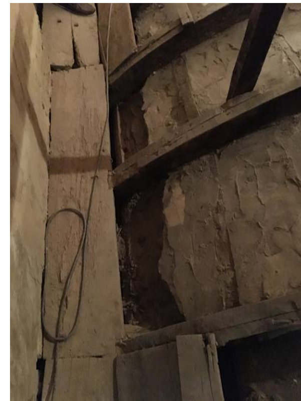
Orditura di sostegno della volta all'estradosso costituita da travetti accoppiati e sagomati a centine sull'andamento delle volte. Sono in buone condizioni, è prevista la verifica delle chiodature di accoppiamento, il trattamento biocida ed antitarlo, la piccola riparazione nelle parti scheggiate o mancanti
