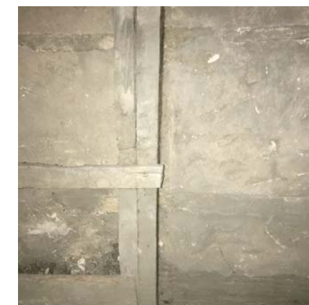
Dettagli degli ancoraggi tra l'orditura trasversale e longitudinale di sostegno ed armatura all'estradosso della volta. Sono in buone condizioni, è prevista la verifica delle chiodature di accoppiamento, il trattamento biocida ed antitarlo, la piccola riparazione nelle parti scheggiate o mancanti
