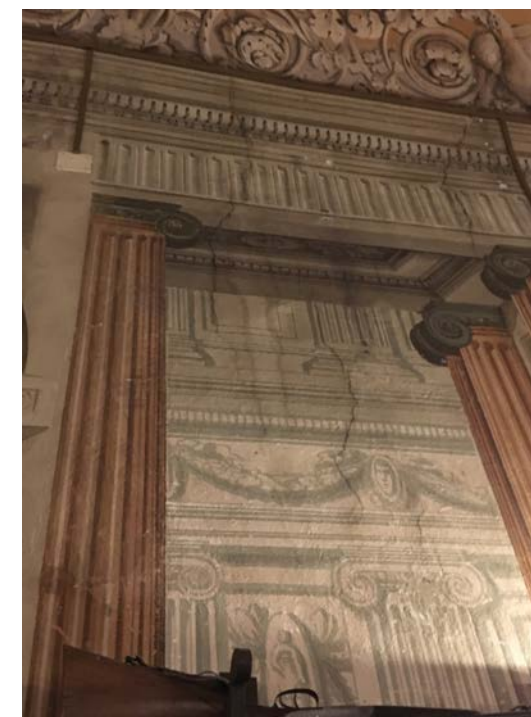
Prospettiva sulla parete
