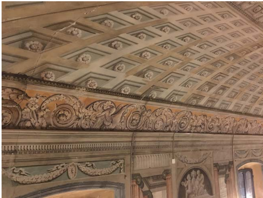
Vista dello stato della volta
