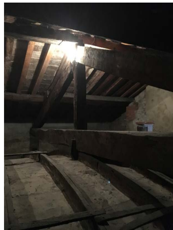
Capriate lignee di copertura dopo i trattamenti biocidi, la disinfestazione e la pulizia. Si presentano in buone condizioni strutturali, sono previsti interventi di verifica degli appoggi e dei nodi e il trattamento antitarlo.
