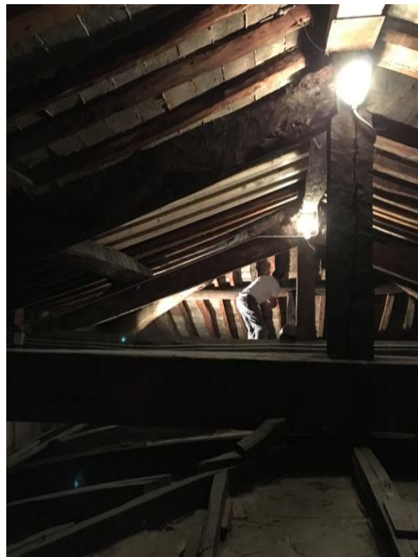
Capriate lignee di copertura dopo i trattamenti biocidi, la disinfestazione e la pulizia. Si presentano in buone condizioni strutturali, sono previsti interventi di verifica degli appoggi e dei nodi e il trattamento antitarlo.
