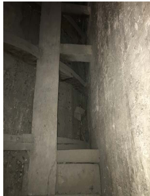
Camminamento perimetrale all'estradosso della volta. Mancano alcune parti di assito e in alcuni tratti le reni della volta sono piene di detriti e oggetti. L'intervento prevede la pulizia dei detriti e la sostituzione o integrazioni delle parti di assito ammorlate o mancanti con legno stagionato di ugual essenza. Successivamente l'intero impalcato perimetrale verrà trattato con biocidi e antitarlo.
