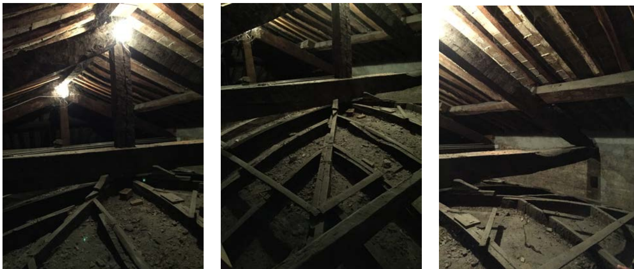
Viste della struttura all'estradosso della volta affrescata
