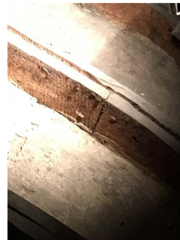
Orditura di sostegno della volta all'estradosso costituita da travetti accoppiati e sagomati a centine sull'andamento delle volte. Sono in buone condizioni, è prevista la verifica delle chiodature di accoppiamento, il trattamento biocida ed antitarlo, la piccola riparazione nelle parti scheggiate o mancanti
