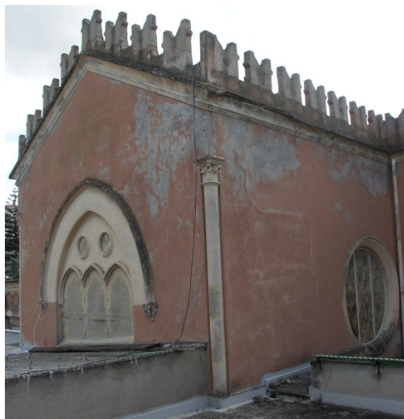
Stato di conservazione ante operam
