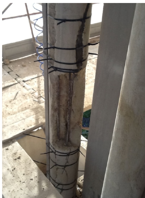
Cerchiaggio e incollaggio delle parti distaccate dei fusti di colonna
