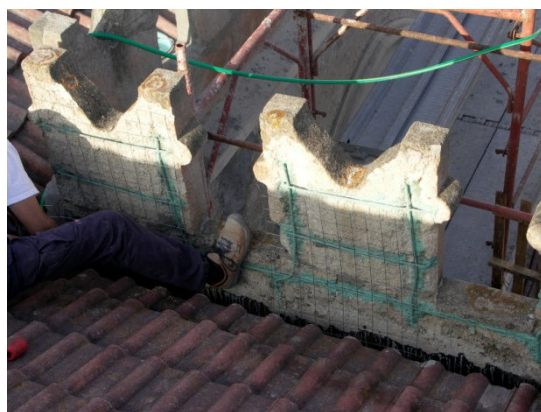
Fase di trattamento dei ferri d'armatura e rinforzo con rete zincata
