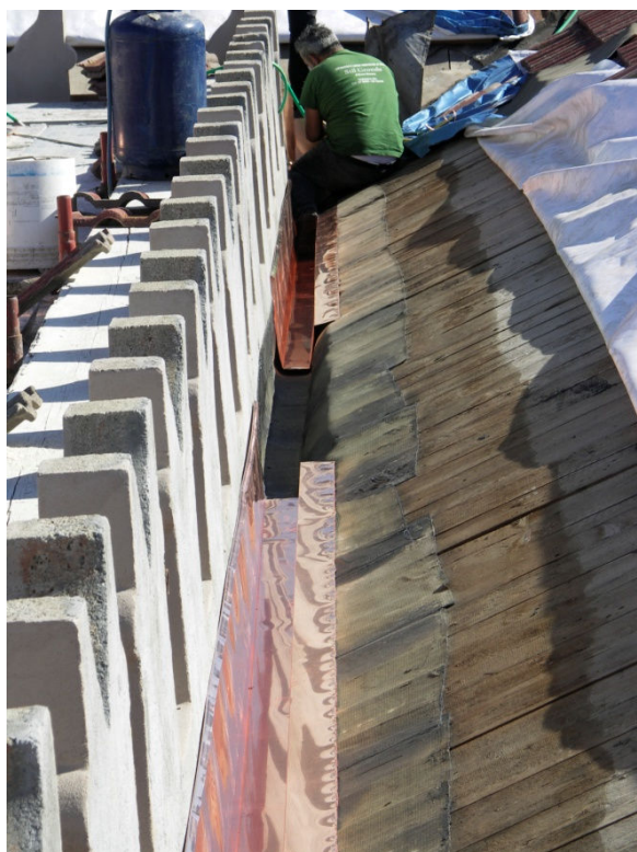
Fase di montaggio del canale di gronda interno
