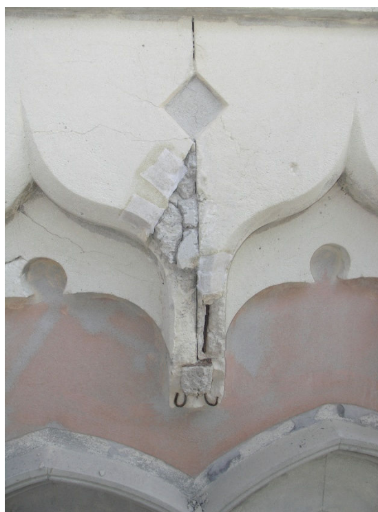
Intervento sulla fascia a rilievo posta sulla torre
