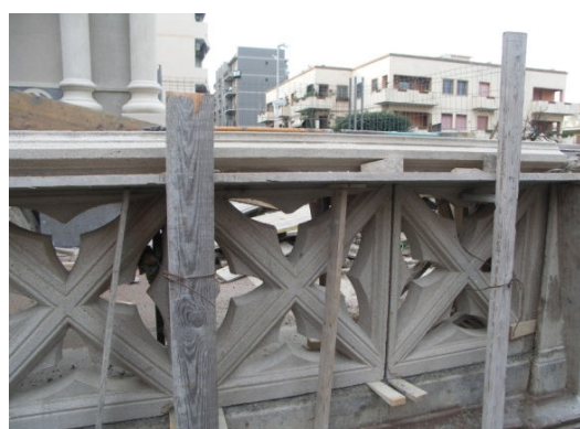
Fasi di ricostruzione dei moduli della balaustre
