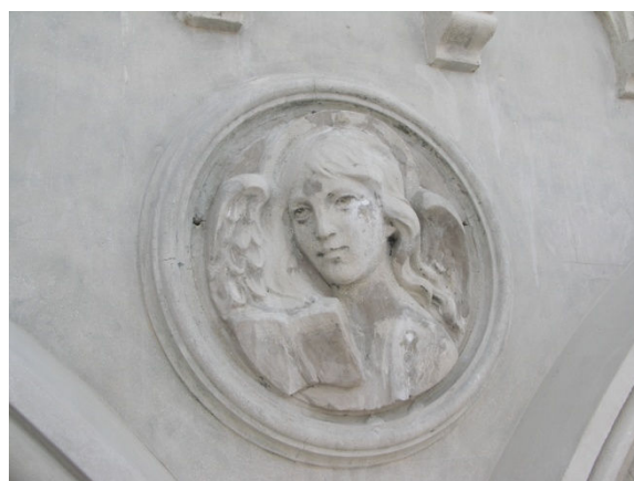
Restauro del medaglione sulla facciata principale
