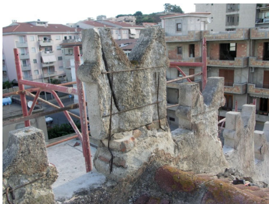
Merlatura vista lato interno dopo la demolizione controllata
