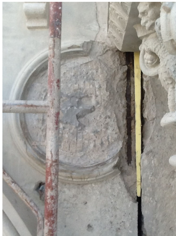
Distacco del medaglione per la formazione del giunto di dilatazione
