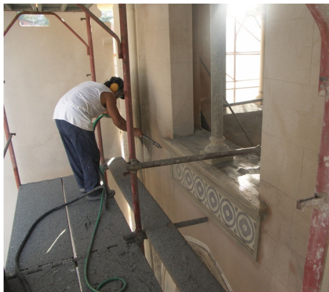
Pulizia mediante sistema Jos
