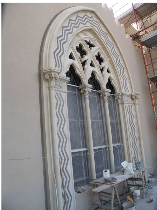
Completamento del restauro della finestra principale
