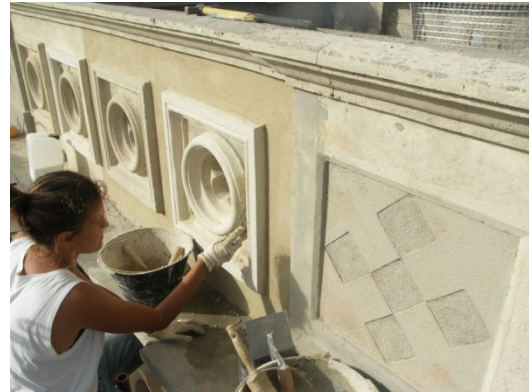
Fase di restauro della balaustra B2
