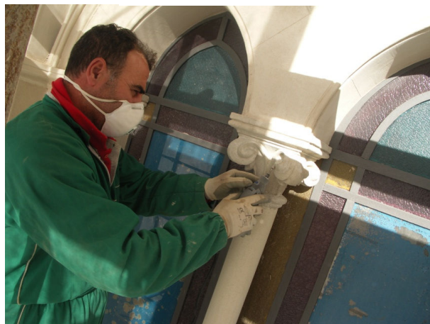
Abrasion e finitura a graniglia della colonnina
