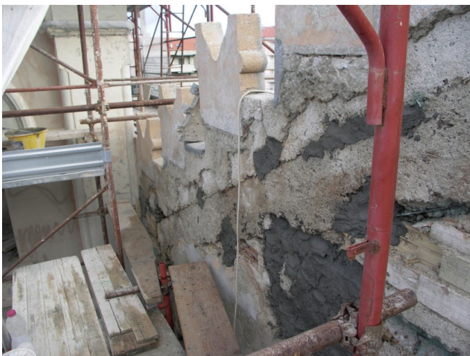
Intervento sulle parti strutturali del timpano centrale
