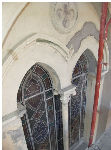
Fase di restauro dei decori delle finestre
