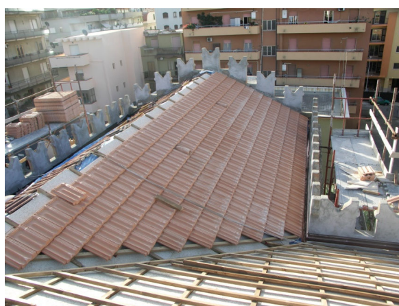
Stratificazione del nuovo manto di copertura
