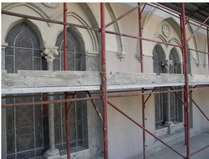
Fondi di facciata completi di rasatura
