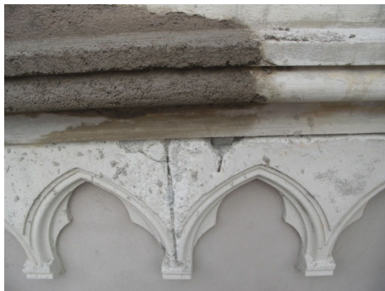
Ricostruzione di parte della cornice sotto il parapetto
