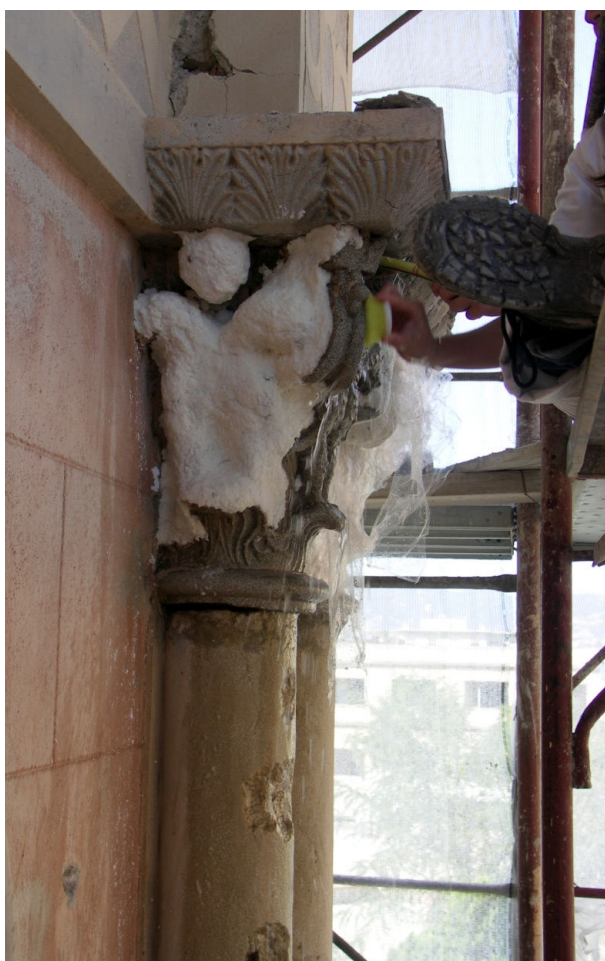
Pulizia mediante impacchi chimici e polpa di cellulosa
