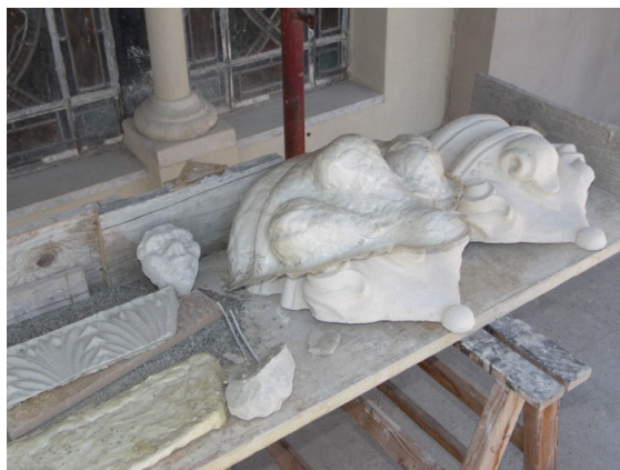
Ricostruzione di un elemento decorativo mancante
