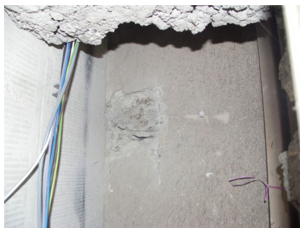
Intercapedine dove è stato prelevato il campione d'intonaco originario
