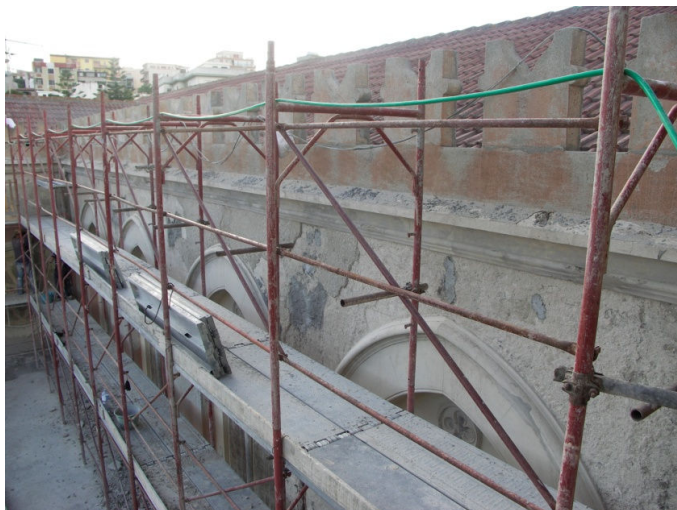
Fase di restauro dei fondi intonacati
