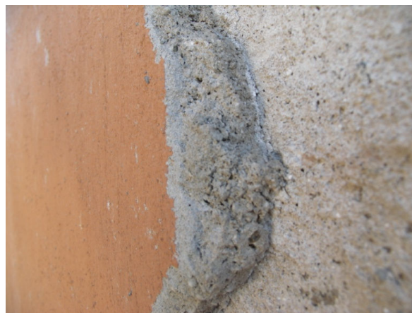
Stratificazione dell'intonaco prima dell'intervento
