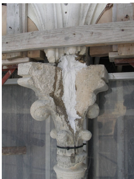
Incollaggio degli elementi distaccati del capitello di finestra
