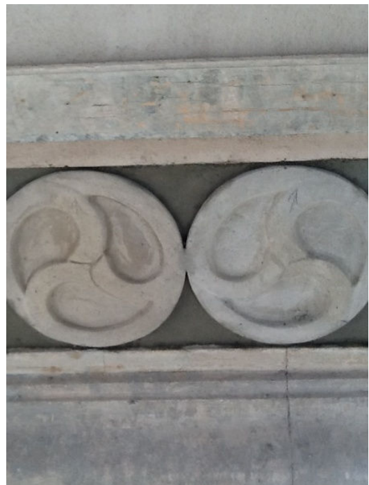
Fase di restauro della fascia sopra la zoccolatura
